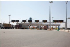
Acceso por V-30 (circunvalación a Valencia)
